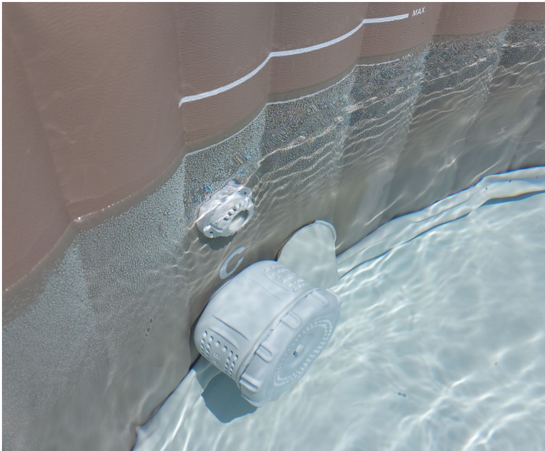
Filterkartuschenbehälter falsch montiert:
